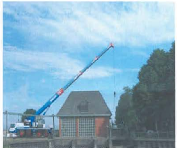
Schöpfwerk "Mühlenhaus" Montagearbeiten 2004
