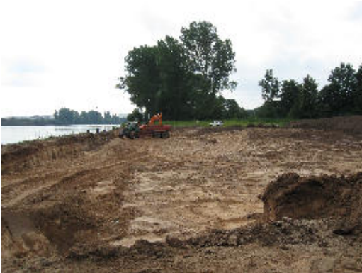
Uferrenaturierung Rablinghausen, kurz nach Baubeginn
